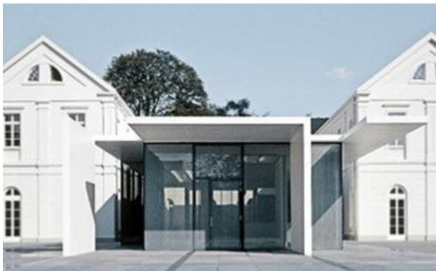
Abbildung 36 Vordach als starrer Sonnenschutz 85
